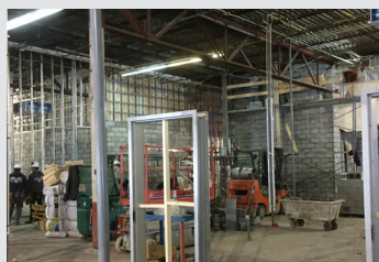
Construction des divisions
