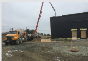
Construction des trottoirs
