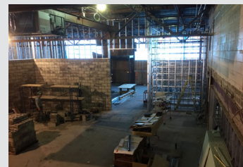
Début de la construction des divisions
